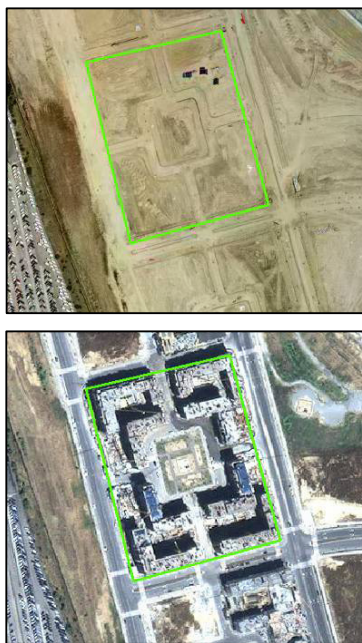
Figura 2: Detección de cambio correspondiente a “obras en edificios de nueva planta”.
